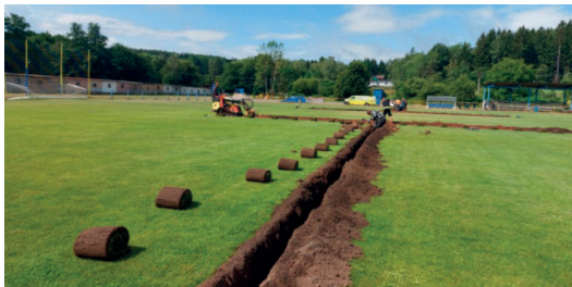
Výstavba nového automatického závlahového systému
